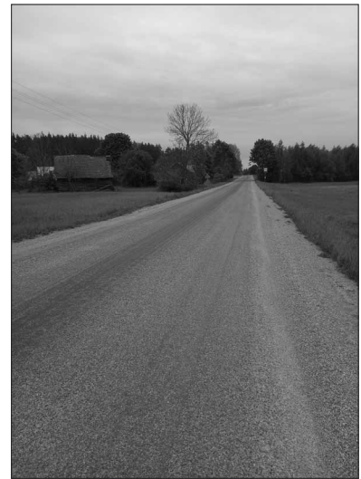
Droga do Wiejek po remoncie
