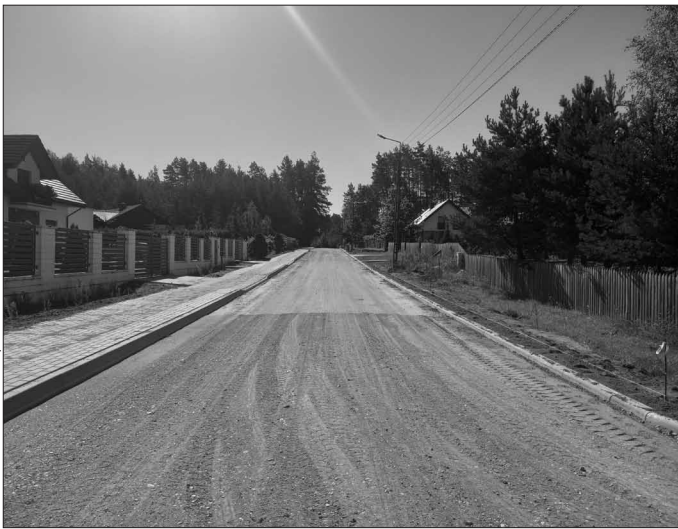
Remont drogi gminnej w Downiewie
