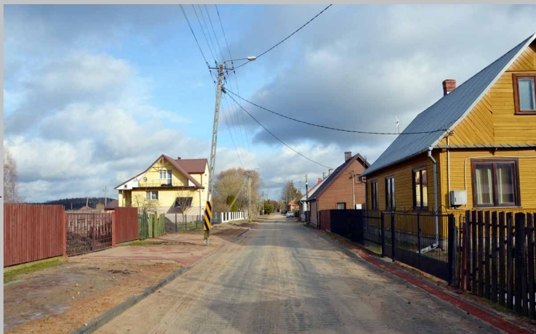
Ulica Błotna po remoncie
