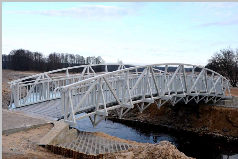
Nowa kładka pieszo-rowerowa na rzece Supraśl
