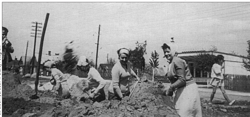
Na placu budowy domu kultury
