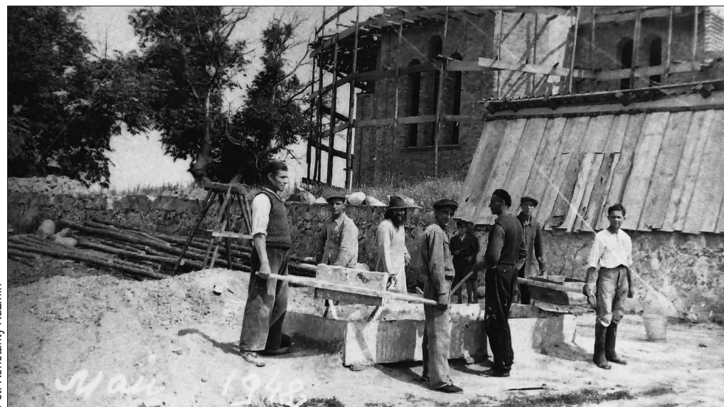
Budowa cerkwi w Gródku
